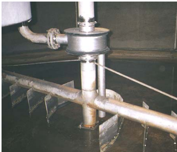
En centrumdriven slamskrapa inmonterad i en sedimenteringsbassäng av rostfritt stål. Den runda burken på slamskrapaxeln är slamboxen.
