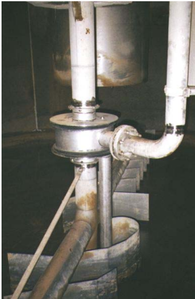
En centrumdriven slamskrapa inmonterad i en sedimenteringsbassäng av rostfritt stål. Den runda burken på slamskrapaxeln är slamboxen.
