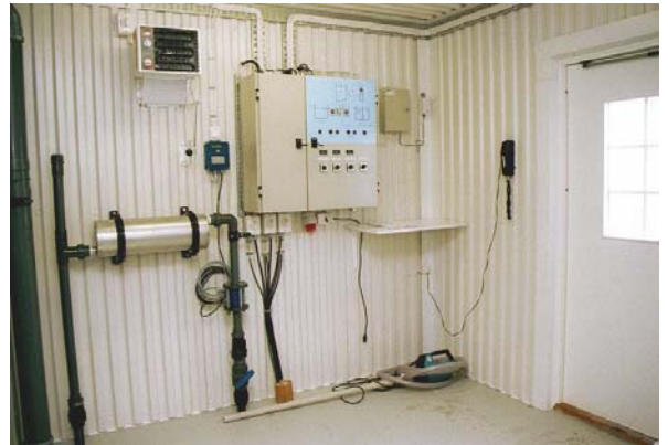
Från vänster syns den statiska mixern, flödesmätaren, automatiken och skrivhyllan.
