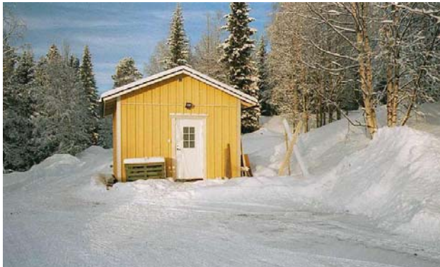
Överbyggnaden till Borgvattnets avloppsreningsverk
