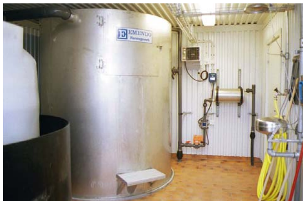
Biobädden, byggd i rostfritt stål SS2333.
