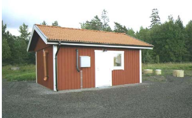
Överbyggnaden till Bottnas avloppsreningsverk med kemsedimenteringen i bakgrunden.
