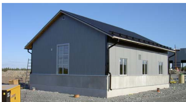
Överbyggnaden till det nya avloppsreningsverket.
