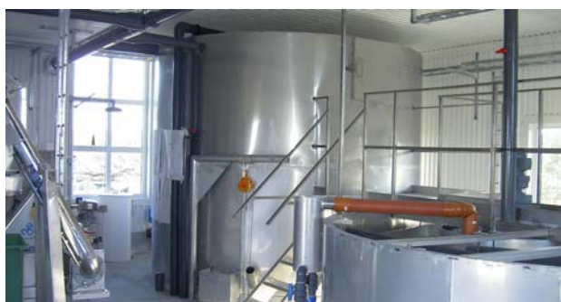
Biobädden, byggd i rostfritt stål. Trappa och plattform för total åtkomlighet i anläggningen.
