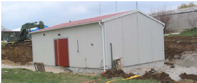
Överbyggnaden till det nya avloppsreningsverket på Camp Victoria i Pristina, Kosovo.
