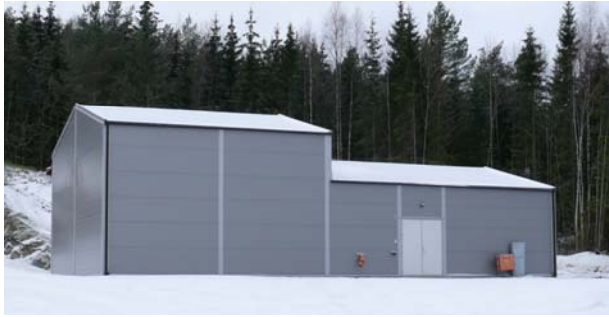
Överbyggnaden till det nya avloppsreningsverket för Nordby köpcenter i Strömstad.
