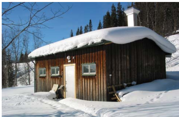
Överbyggnaden till det ombyggda reningsverket i Stora Blåsjön.
