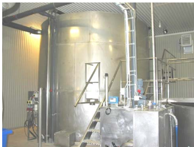
Biobädden är byggd i rostfritt stål och rymmer c:a 40 \text{ m}^3 .
