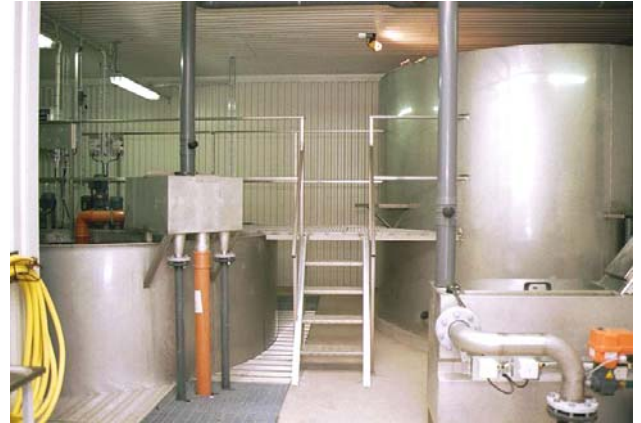
Sedimenteringsbassängen till vänster och bio- bädden till höger.
