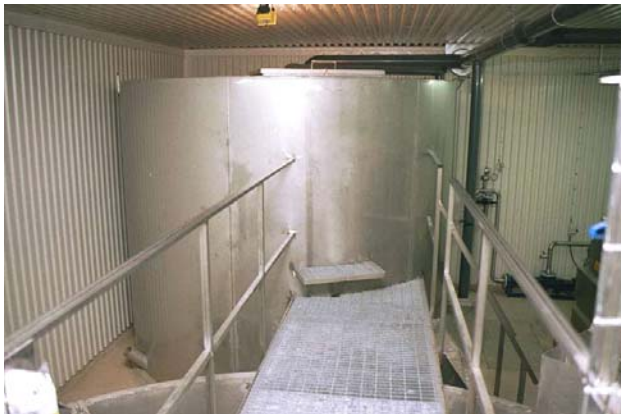
Biobädden, byggd i rostfritt stål SS2333. Trappa och plattform för total åtkomlighet i anläggningen.
