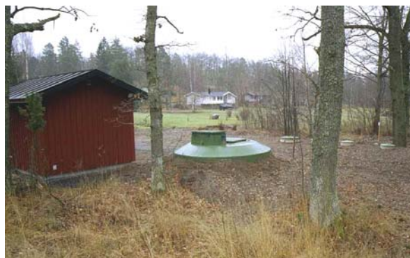
Reningsverket med några av fritidshusen i bakgrunden.
