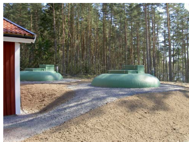
Bilden visar de två symmetriskt anlagda biobäddarna. De är anslutna till var sin linje.
