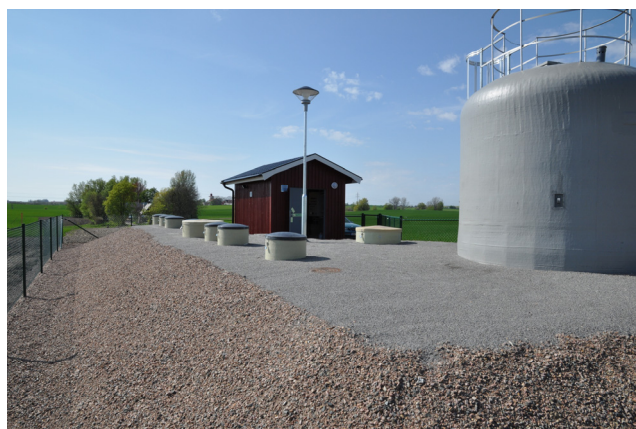
Biobädden till höger, utförd för kvävereduktion.
