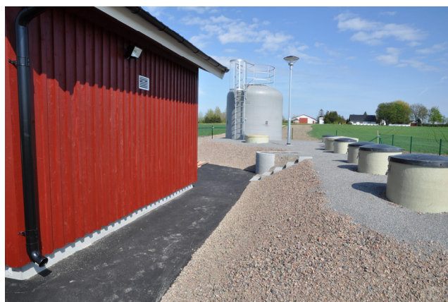
Servicebyggnaden till vänster, innehållande all maskinell utrustning.
