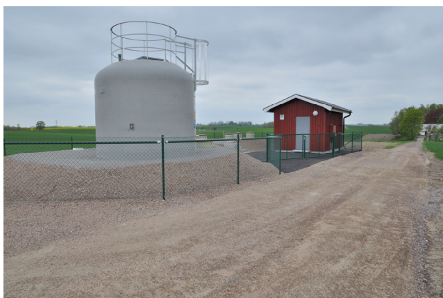
Infartsväg till reningsverket.
